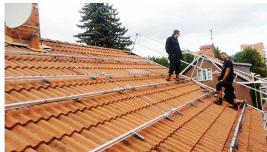
Skensystemet placeras med ett visst mellanrum för att tåla snölasten i Dalarna, här monteras de av Daniel Öhrn, Joar Nyman och Manne Staffansson.
