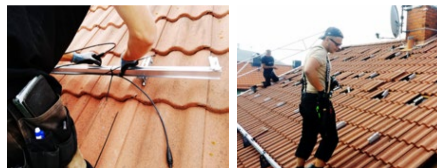
Här förbereds DC-kablarna på taket där strängen ska börja och sluta. Solpanelerna seriekopplas i en eller flera strängar beroende på storleken på montage och eventuella skuggningsfaktorer. I detta fall endast en sträng. DC-kablarna kopplas senare in i växelriktaren som kommer omvandla likströmmen som solpanelerna producerar till växelström.
